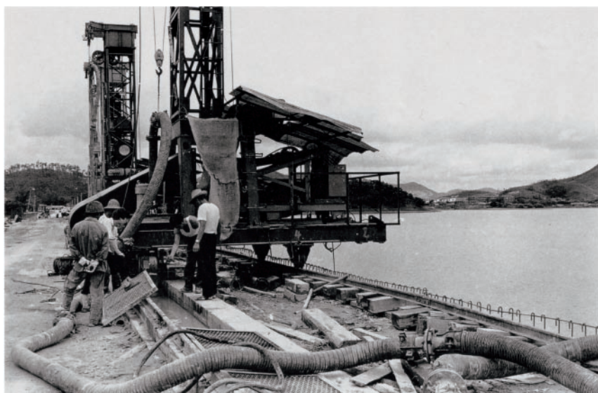
深圳水库大坝是1960年建设的，为扩大库容，在上世纪80年代进行了加固。
