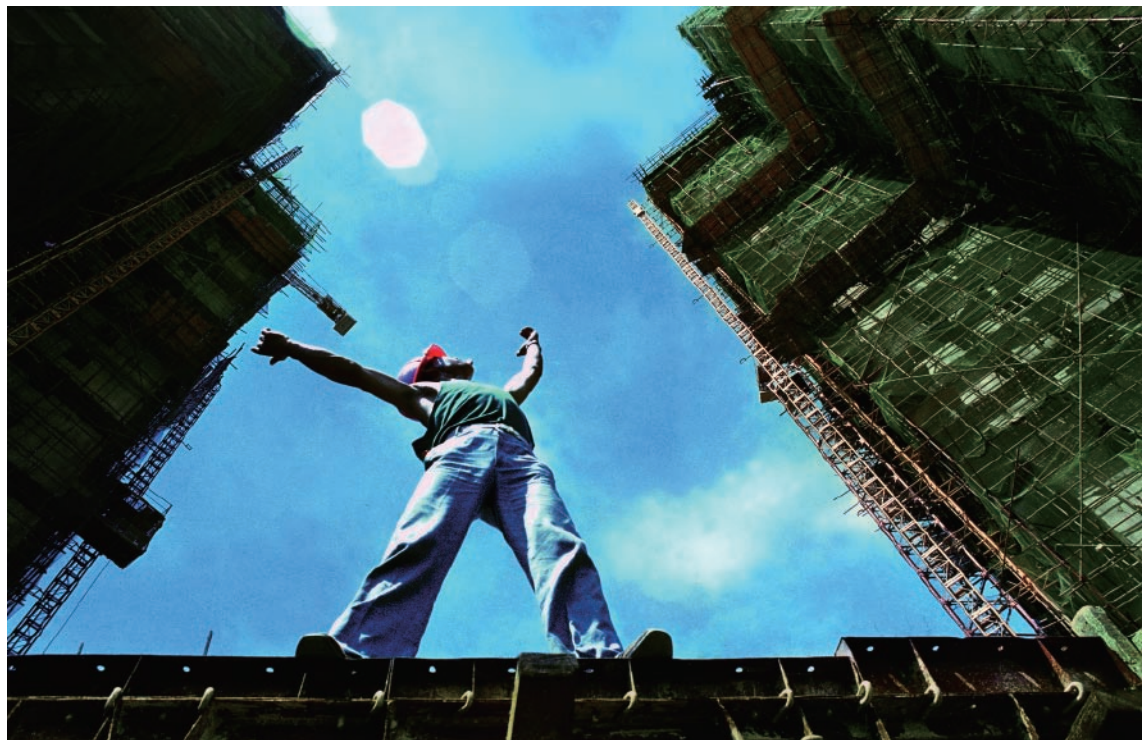
1984年，一位基建兵转业的吊车指挥员正在市一建红岭大厦施工工地上指挥着。此时，深圳的建设正热火朝天。
