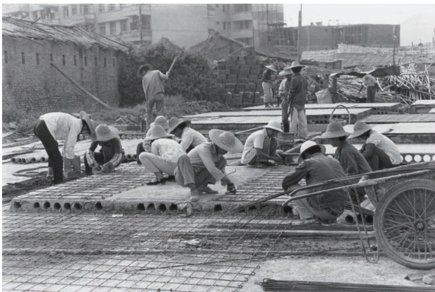
1981年，工人在深圳通新岭建造居民小区。
