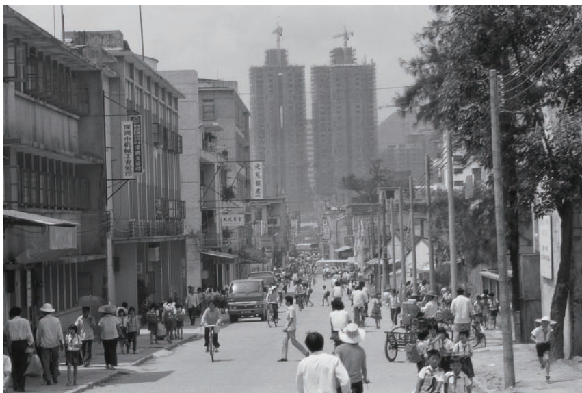
1983年，深圳人民路北段老街。不远处的高楼大厦正在兴建。
