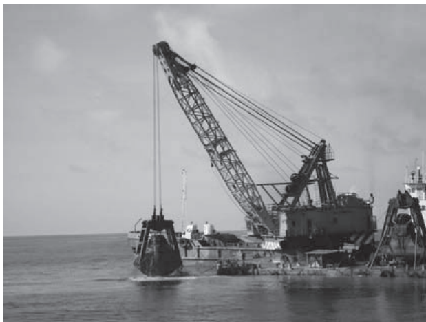
挖泥船正在挖泥
