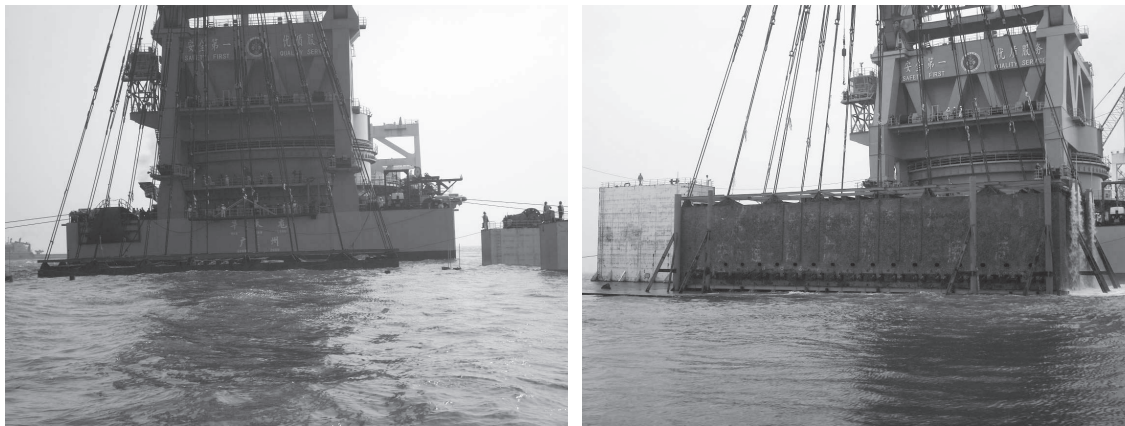
“华天龙号”起吊钢井过程图
