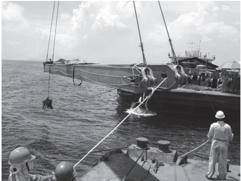
千斤顶架和底托梁在安装过程中均使用的锚链
