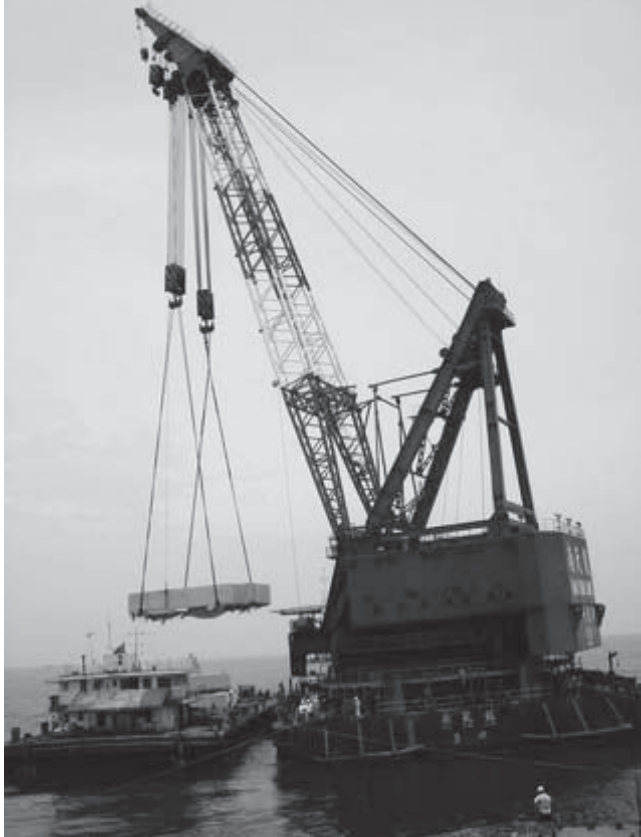
“南天龙号”吊水泥压重块静压
