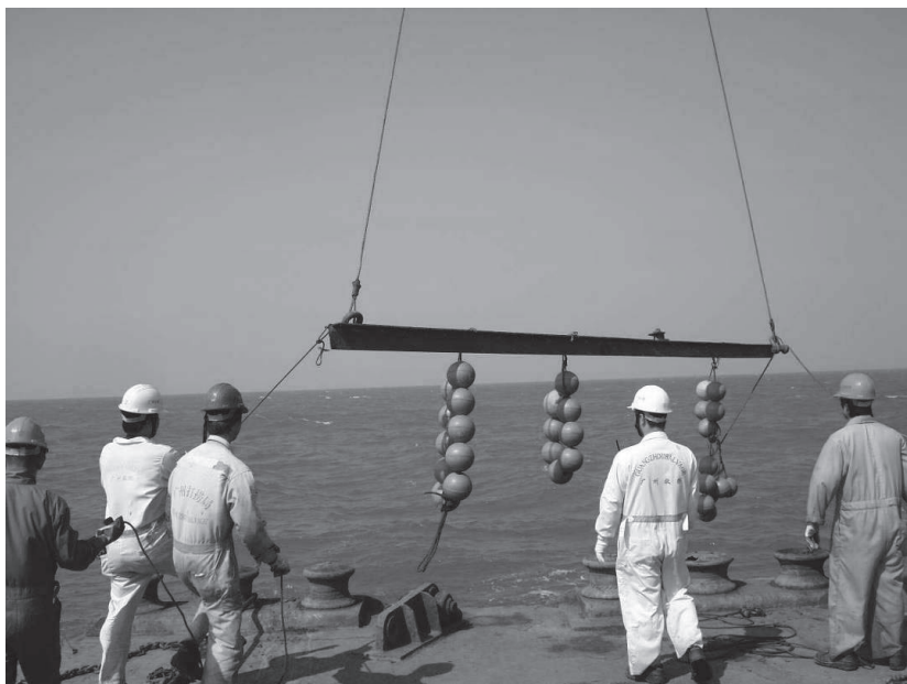
“弓箭式”穿引的保泥板吊放入水
