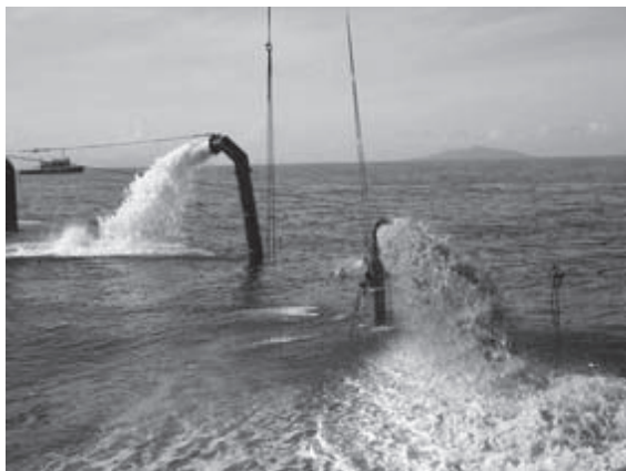
“南洋号”和“南天柱号”同时抽泥
