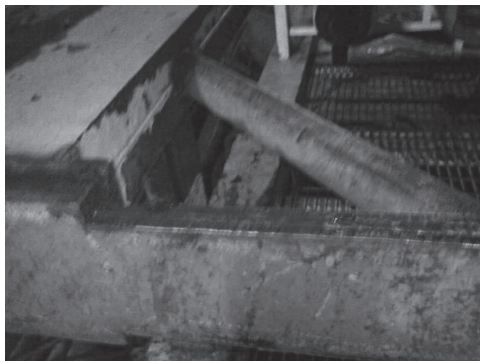
改良后的千斤顶横梁
