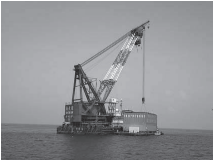
“南天龙号”起吊钢沉井前
