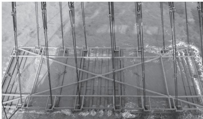
钢沉井16个吊点完成卡接
