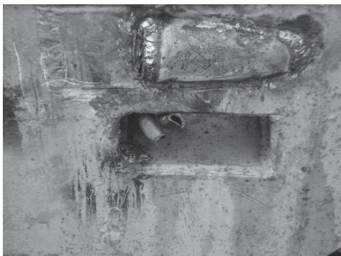
喷水管的侧面喷头
