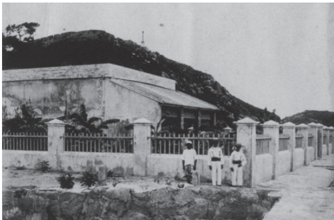
位于妈屿岛的 海关楼
