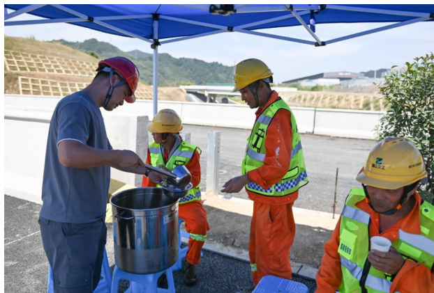
7 月 14 日，在临建高速土建一标项目现场
