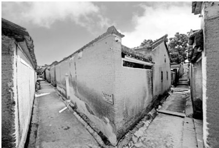
图4 夯土墙古民居
